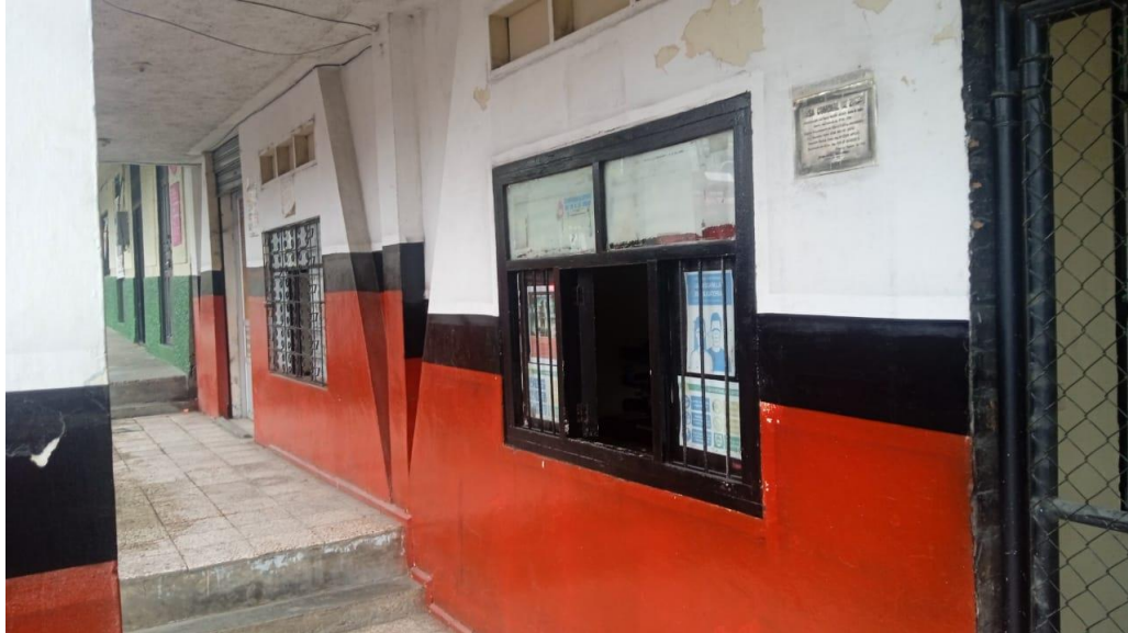
Grafico 61: Fachada de las oficinas administrativas del CBCCC
